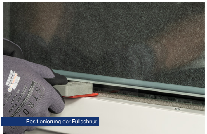
Einbringen der Füllschnur
