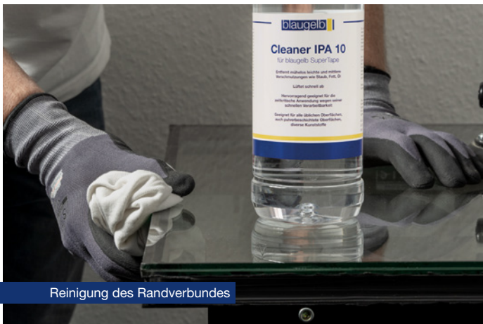
Reinigung des Glasfalzes
